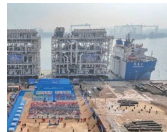
加拿大 LNG 项目交付现场
